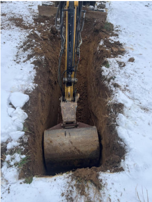
Schurf 2 ( Bereich Bauplatz Painsi, südlich )
