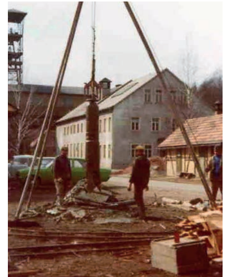
Bohrung für die Untergrunduntersuchung 1976
