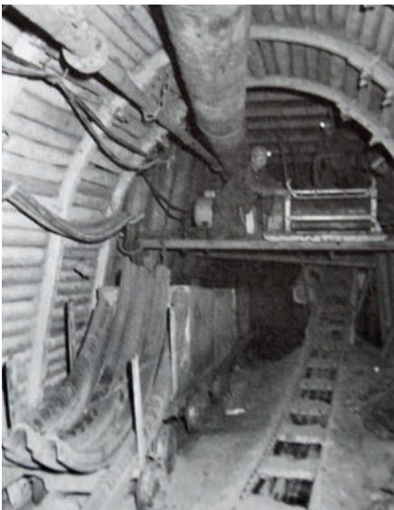
Förderstrecke vor der „Raubung“
