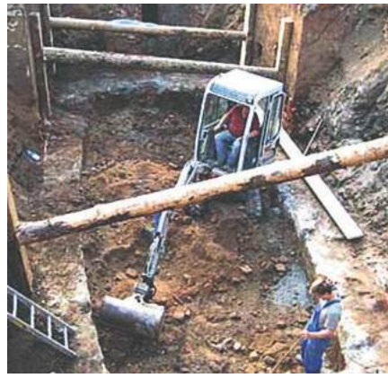
Öffnung des Hauptschachtes
