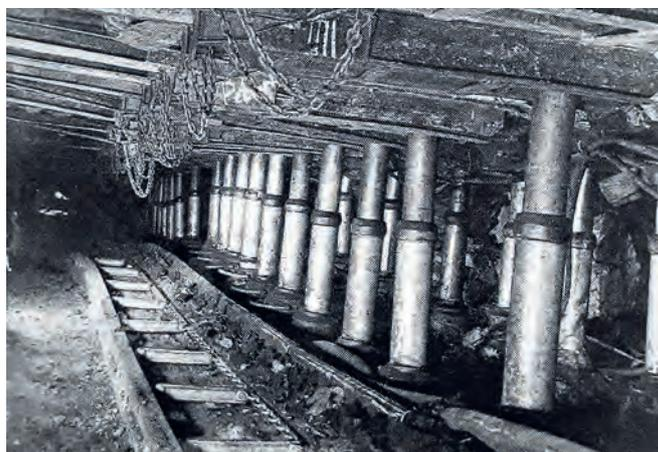
Kettenförderer „Westfalia PF 0“. Zeltweger hydraulische Ausbauböcke.
