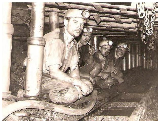
*Streb mit hydraulischen Zwei- Stempel- Rahmen- ausbau 2x 30 Tonnen Setzlast, erster von links Fritz Narath, dritter von links Erich Jahn.*
