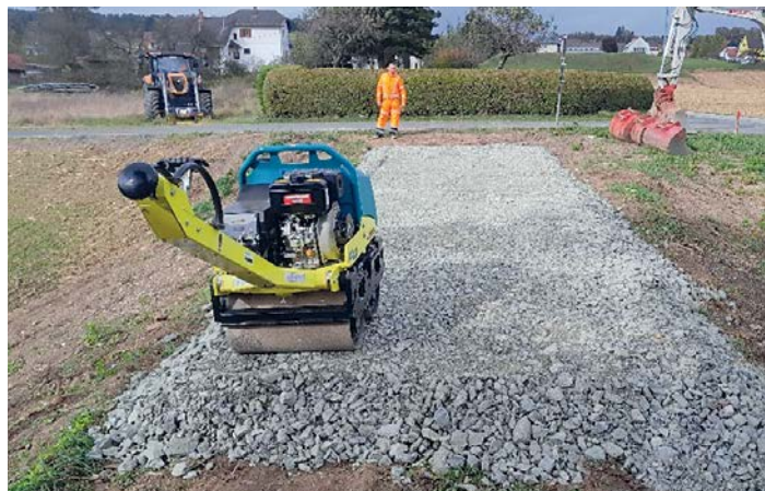
Station „Kohlewaggon“: Gleisbett in Arbeit
